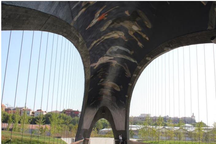
Fig. 14. Puente del Invernadero con decoración de Daniel Canogar, Madrid Río, 2013. Fuente: M.D. Arroyo
