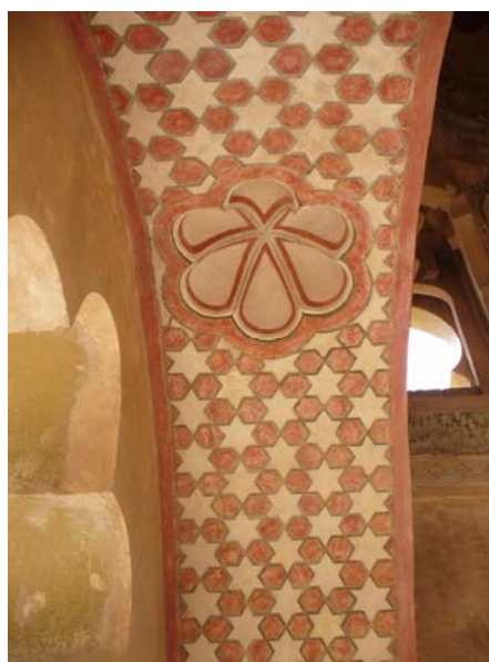
Fig. 4.- Bóveda esgrafiada al interior de la Qubba al-Bārūdiyyīn de Marrakech. (Foto R. Ruiz)
