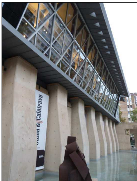
Fig. 9. Fachada actual del IAACC Pablo Serrano.
