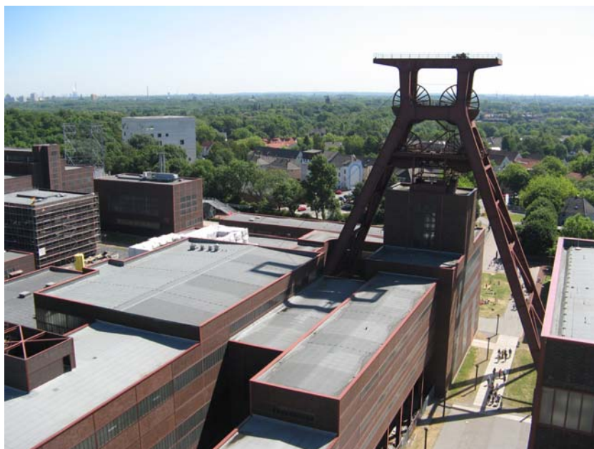
Figuras 9 - 10: Zollverein (Essen, Alemania). Vista de conjunto con la planta de fundición de carbón al fondo, y vista del castillete del Pozo XII declarado Patrimonio de la Humanidad (Foto: A. Layuno).
